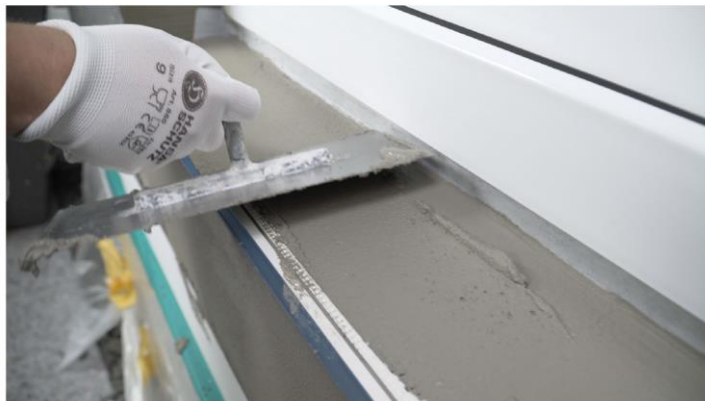
Abb. 1: StoElement Solido F1/F2 - StoProfile Drip F einbetten
