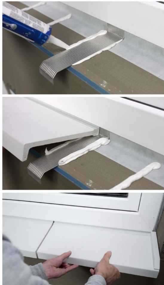
Abb. 5: StoElement Solido F1/F2 - Fensterbänke stoßen
