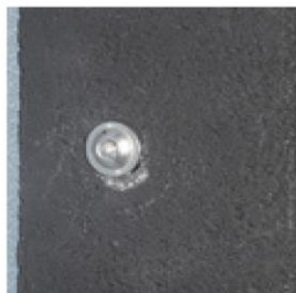
Abbildung 3: Befestigung StoElement Fauna FM-F 20
