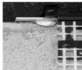
Sto-Fugenflankenprofil-Verbinder dicht am Fugenflankenprofil
