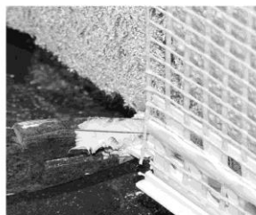
Justieren des Fugenflankenprofil- Verbinders
