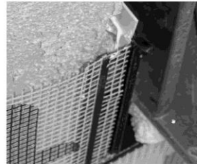
Eingebautes Eckstück mit Fugenflankenprofil-Verbinder
