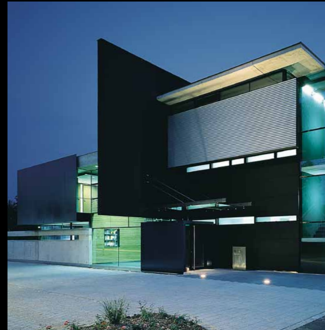
Hitzeschild für die Fassade: StoColor X-black hat die Fähigkeit, eine von Sonneneinstrahlung verursachte Temperaturspitze unter 70 °C zu halten.
