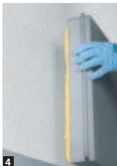
Dämmplatten ansetzen - fertig
