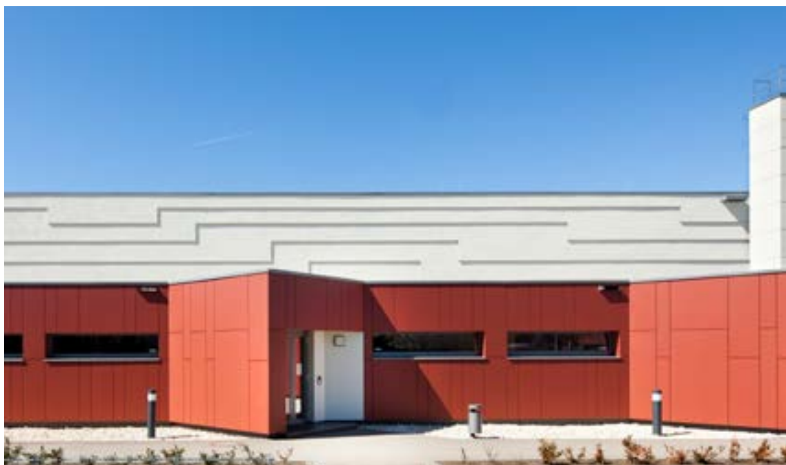
Alemannenhalle, Stetten am kalten Markt, DE Bauherrschaft: Gemeinde Stetten a. k. M., DE Architektur: dk architekten, Stuttgart, DE Fachhandwerk: MAUCH-MÄRTE GmbH, Sipplingen, DE Sto-Kompetenzen: StoTherm Classic®; StoSignature, Texture: Rough 1 Foto: Johannes Vogt, Mannheim, DE
