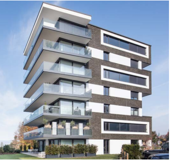
Wohnanlage Straßburgerstraße/Freudenstadt, DE
