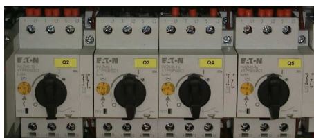
Abb. 1: Motorschutzschalter
