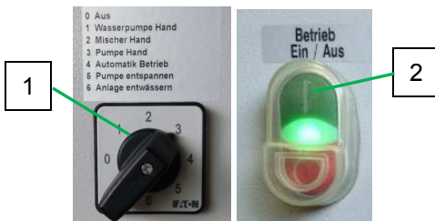
Abb. 52: Stufenschalter
