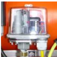
Abb. 104: Druckschalter Luft
