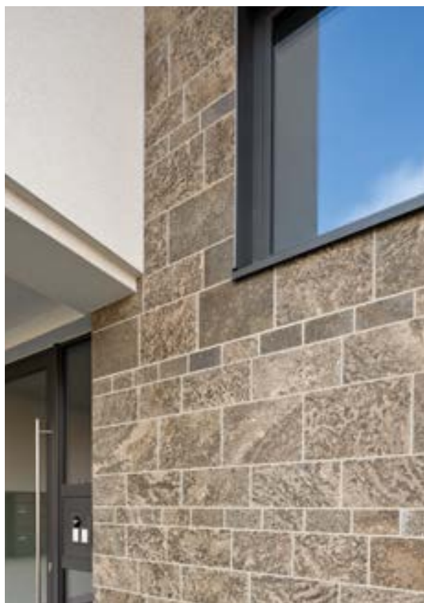
Wohn- und Geschäftshaus, DE-Aschaffenburg
