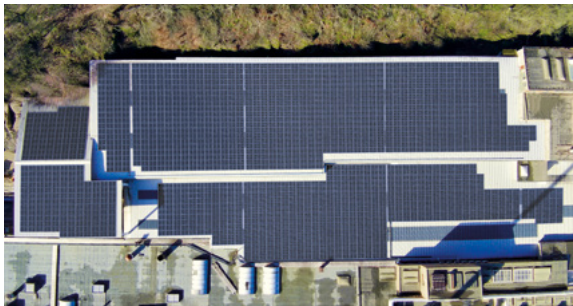
2023 hat die deutsche Tochtergesellschaft Ströher GmbH in Dillenburg Photovoltaikanlagen auf dem Dach installiert. Foto: Ströher GmbH, DE
