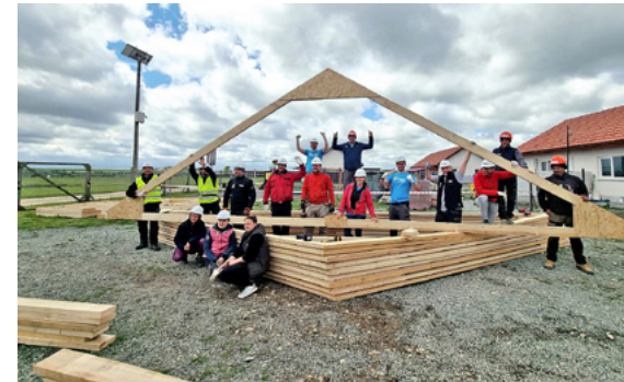
Unsere Mitarbeitenden unterstützen Habitat for Humanity Deutschland und die HoffnungsBAUer bei dem Bau eines neuen Zuhauses für eine rumänische Familie.
