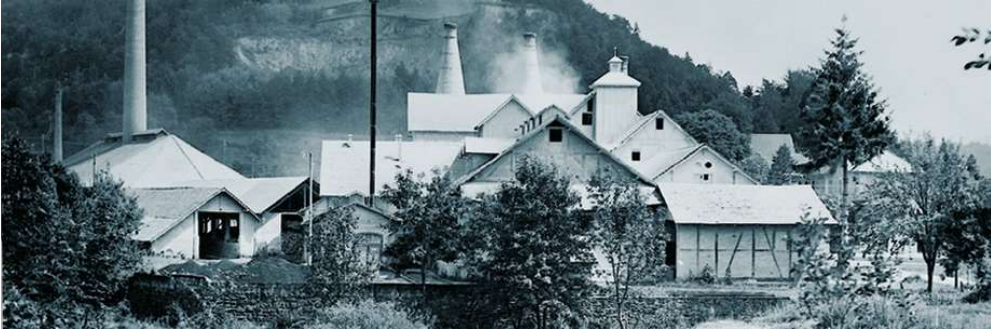
1835: Gründung des Zement- und Kalkwerks in Weizen
