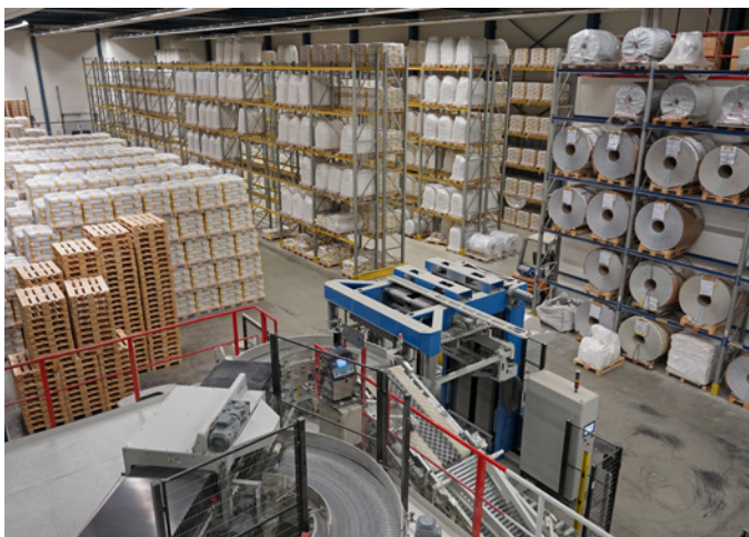
Umfangreiche Retrofit-Maßnahmen liefern auch im Sto-Produktionswerk in Tollwitz Foto: Sto SE & Co. KGaA
