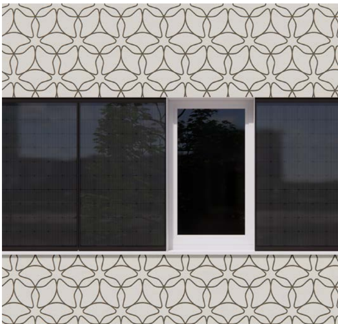
Mischfassade mit vorgefertigten Putzelementen: StoEcoshape
